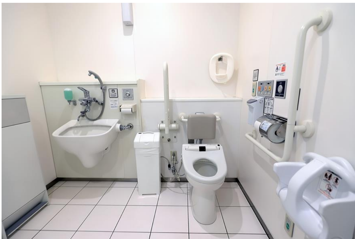
写真:バリアフリートイレの例
